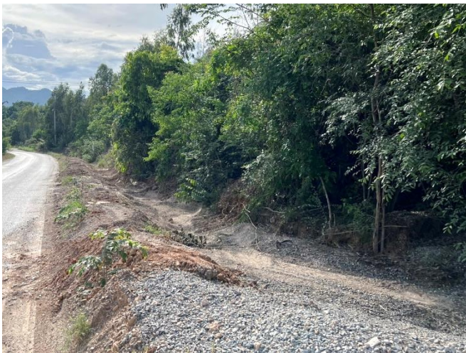
รูปที่ 2-7 ค้นทำนบดิน คุระบายน้ำตามแนวเขตในพื้นที่เว้นการทำเหมือง ในระยะ 10 เมตร
