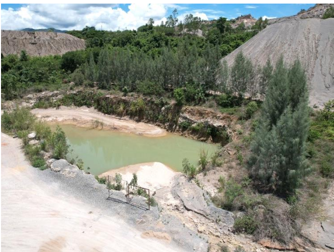
รูปที่ 2-26 คันทำนบดินที่มีการปลูกพืชคลุมดิน และไม้ยืนต้น
