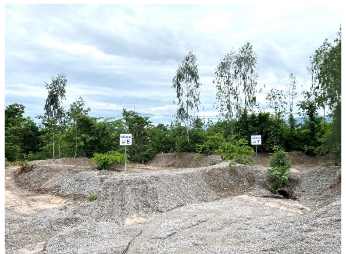
รูปที่ 2-8 (ต่อ) บ่อดักตะกอนเพื่อรองรับรับชะล้างตามแนวเขตในพื้นที่เว้นการทำเหมือง ระยะ 10 เมตร
